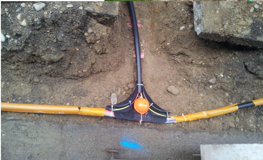
Verlegung von Leerrohr-Infrastruktur
